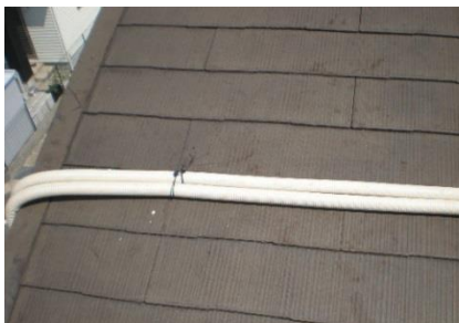
屋根上を這う配管
