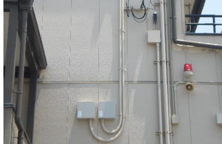
壁を這う配管
