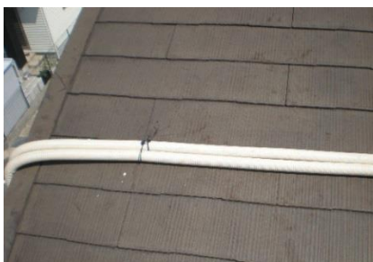
屋根上を這う配管
